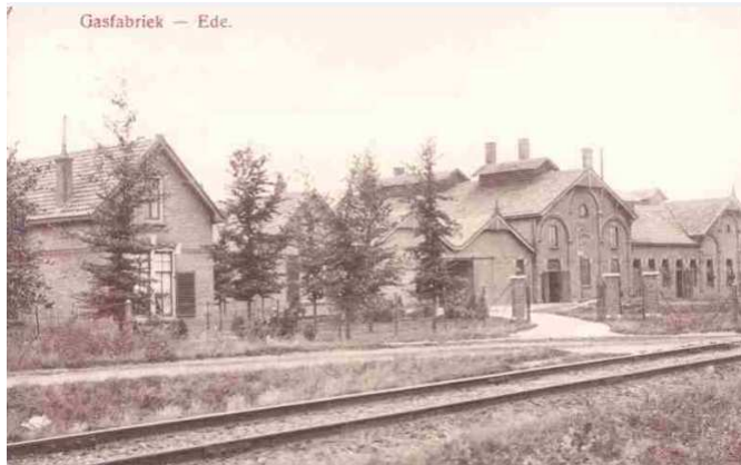
Historische foto van het terrein van de gasfabriek langs de spoorlijn
