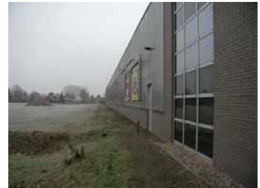
onderkant van de gevel opgebouwd uit bakstenen
