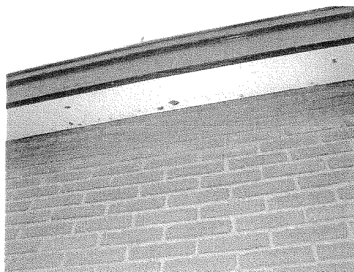
Houten daklijst met geïntegreerde dakgoot aan de noordzijde van het gebouw
