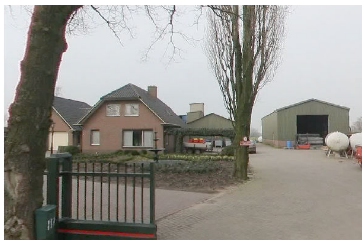
Foto genomen vanaf voorzijde perceel
