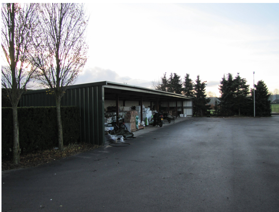
Afbeelding 2. te slopen half open loods
