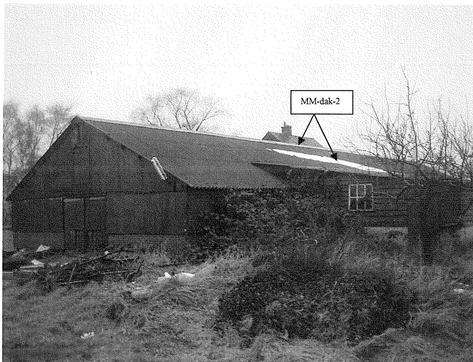
Foto 4: Geïntervieweerde schuur met asbesthoudende golfplaat als dakbedekking vanuit oost-noordoostelijke richting gezien.
