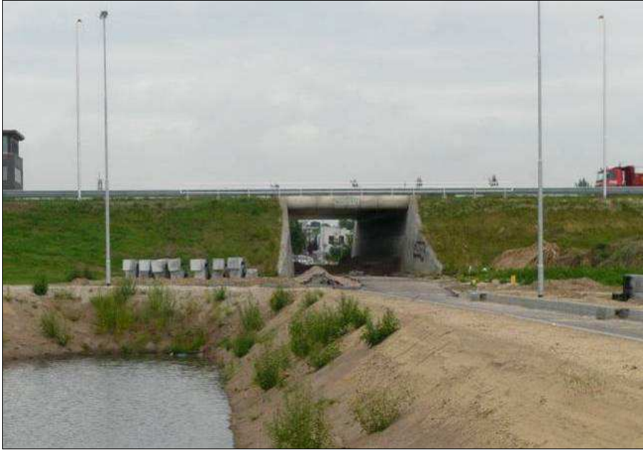
Tunnel voor fiets en bus onder de A30 richting Heestereng, met op de voorgrond de in aanleg zijnde Darwinstraat
