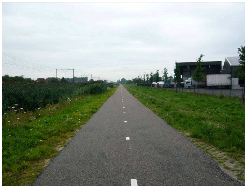
Vrijliggend fietspad langs de spoorlijn Utrecht-Arnhem
