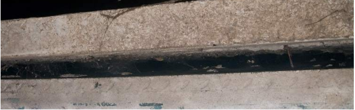
De spouwmuur zit vol met spinrag.
