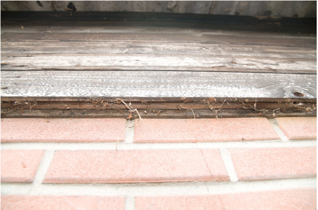
Onder de houten aftimmering is geen ruimte voor vleermuizen
