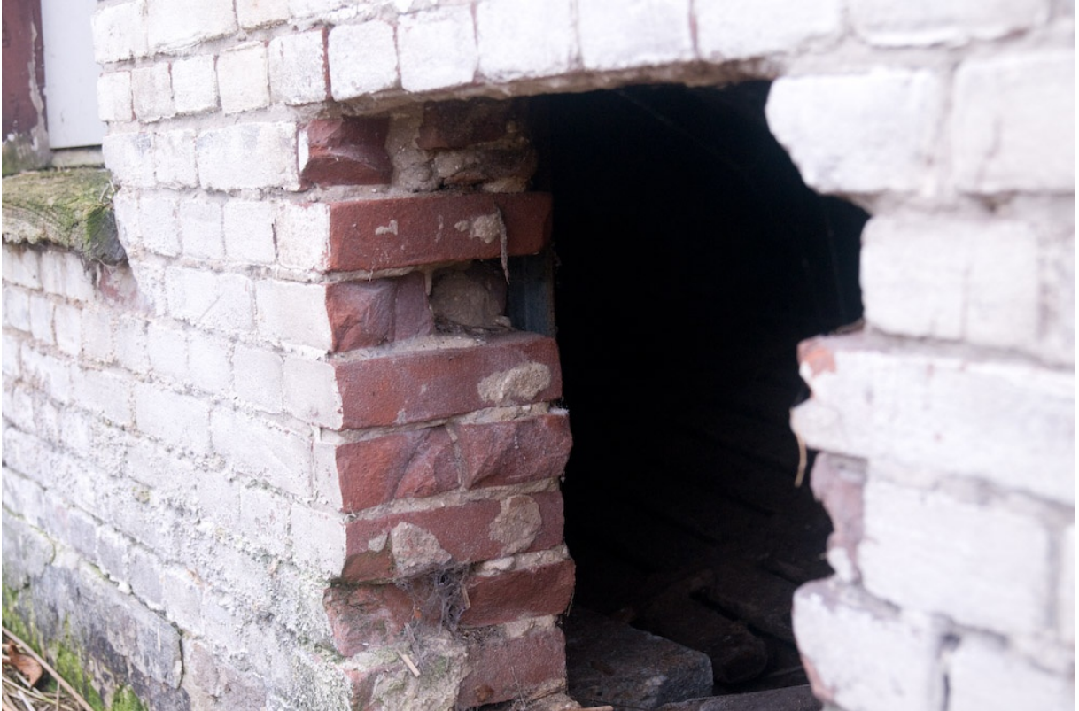
De muren zijn enkelsteens.
