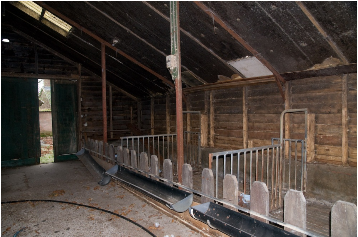
De zijkanten van deze stal bestaan enkel uit houten planken.
