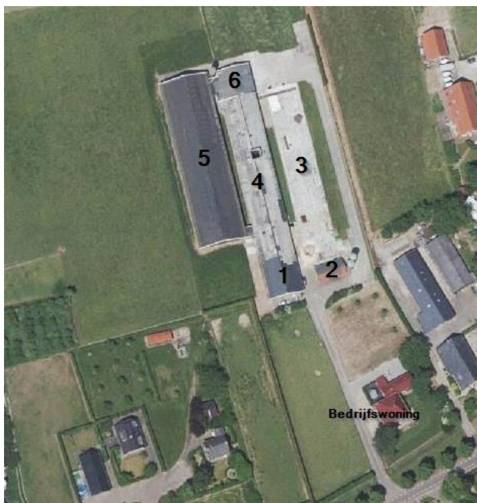
Figuur 2.3: Luchtfoto Loostraat 18 (Bron: PDOK viewer)
