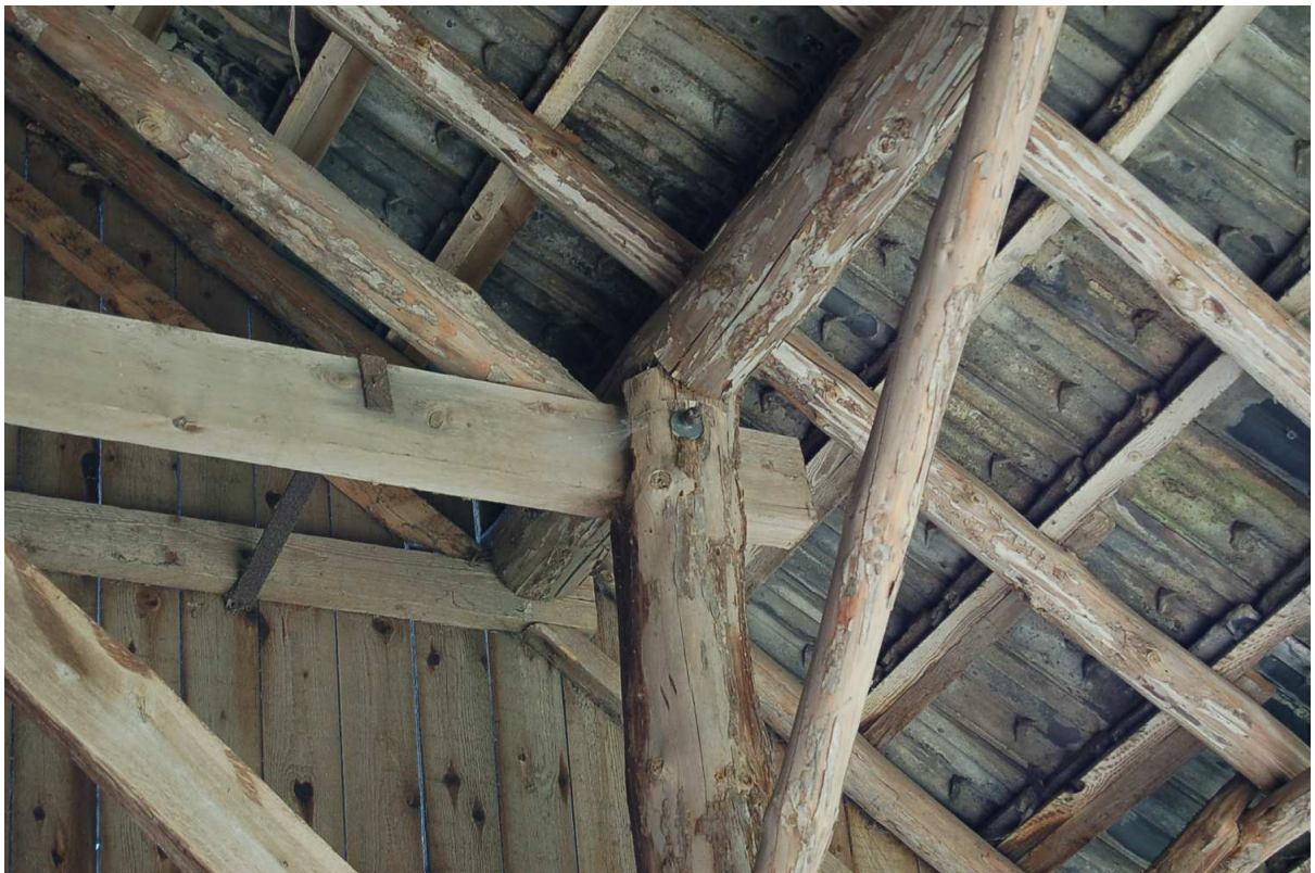
Eenvoudige gebintconstructie wagenloods
