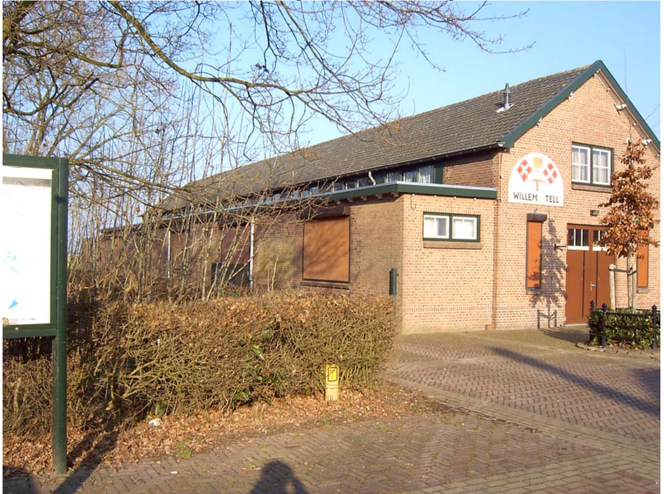
afbeelding 3.1. Overzicht van het schuttersgebouw, zuid- en westgevel
