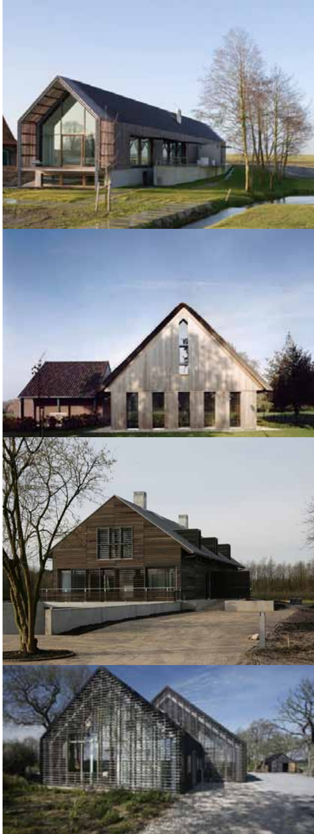
[FIG 13] nieuwe woningbouw met agrarische stijlkenmerken
