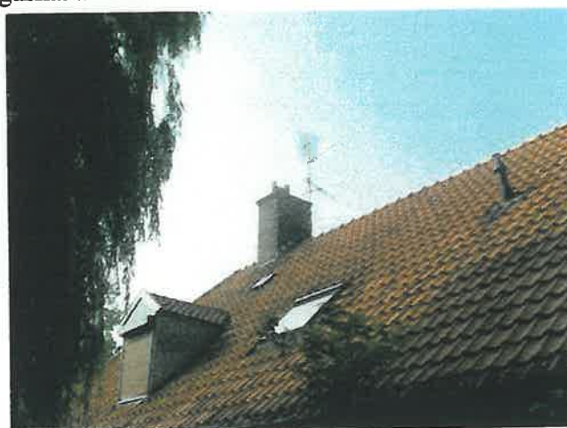
Schoorsteen voorzien van asbest H-kap.
