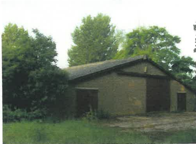
Loopstal voorzien van asbest golfplaat.
