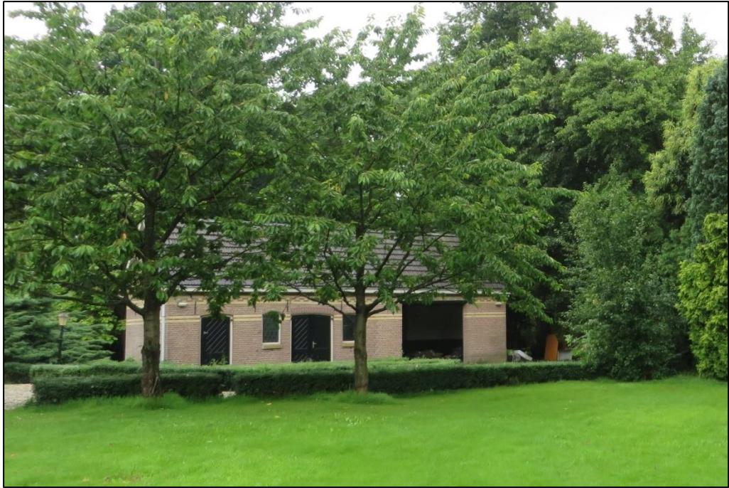
Het koetshuis met pannendak. Foto: SAB, 2016.
