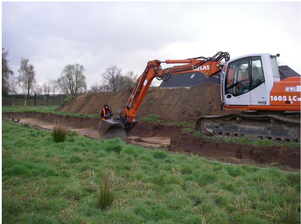
Fig. 4.2: Aanleggen van het vlak met de graafmachine
