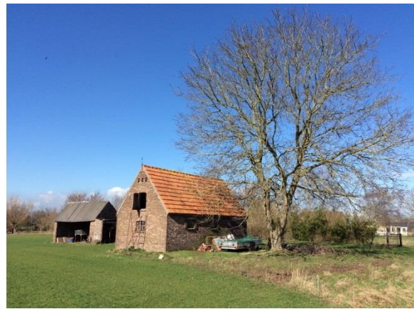
Figuur 9: Overzichtsfoto bebouwing
