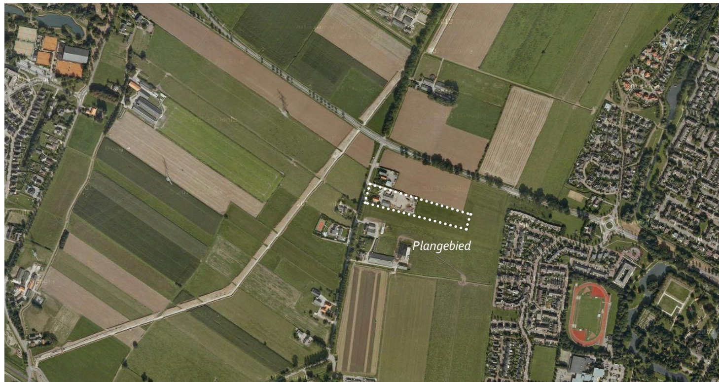
Luchtfoto huidige situatie (NB. De 2 bijgebouwen zijn reeds vervangen door 1 bedrijfshal)
