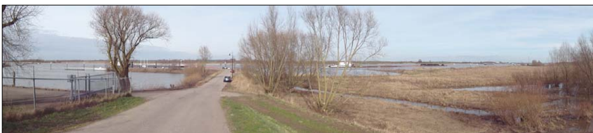
De Veerdam, toegangsweg vanaf de Waalbandijk
