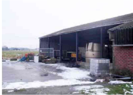
Bedrijfsbebouwing Laarstraat 9, achterzijde
