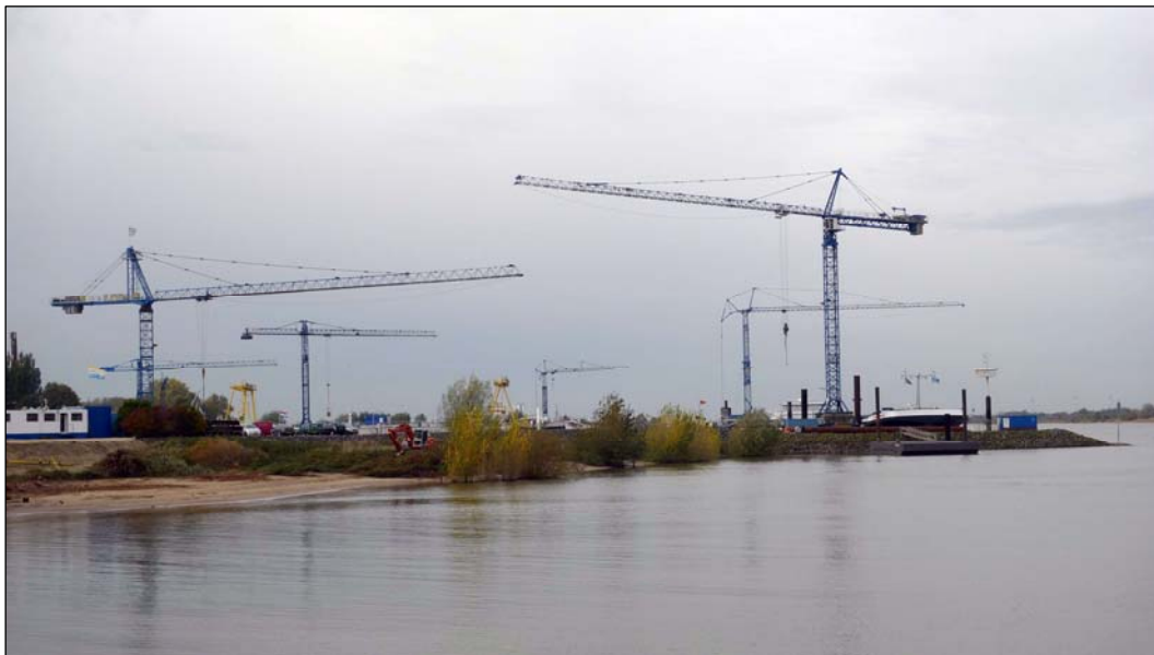
Zicht op de bestaande strekdam, inclusief het ponon, gezien vanaf de Veerdam
