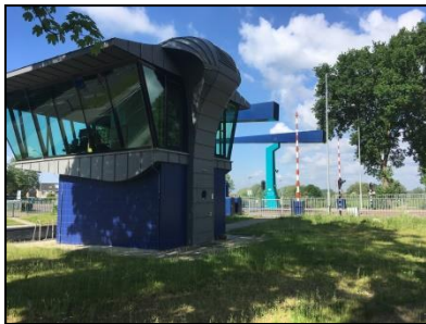
Figuur 9. Bedieningsgebouw, oostelijk terreindeel.
