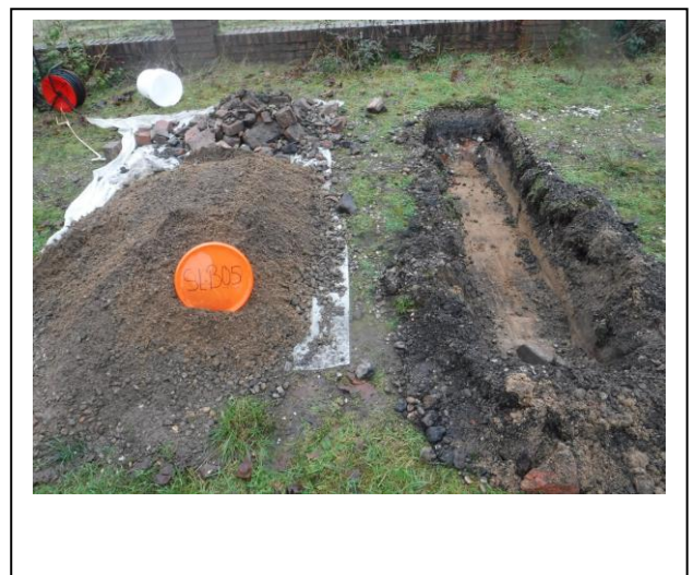
Foto: Inspectiegat SL-B05 (grof puin)
