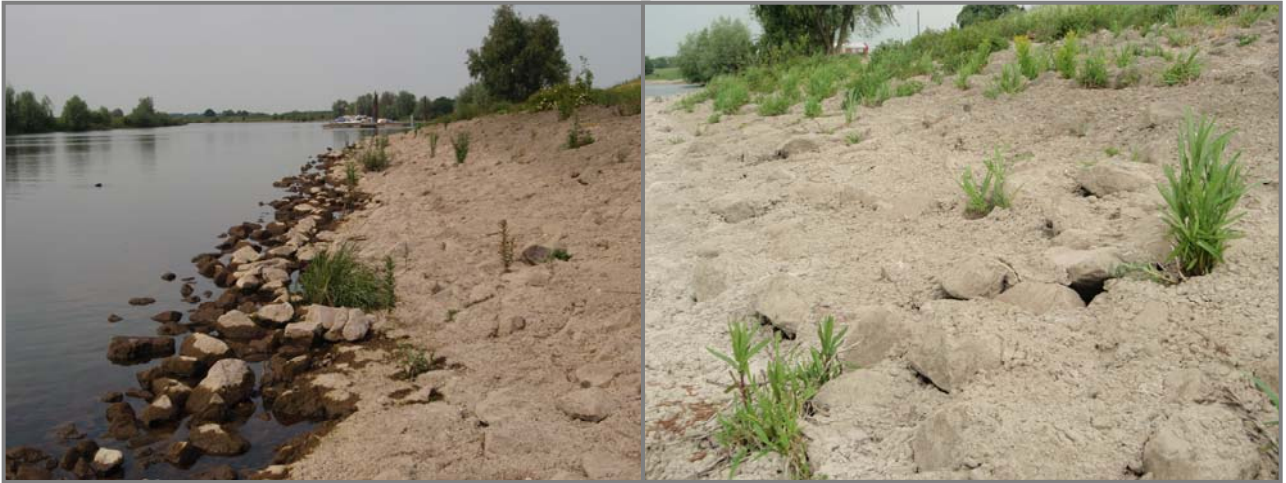
In beton gegoten steenhelling
