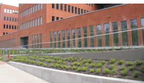
Referentie 8: Trappen en talud Referentie 9: Onderhoudsvrij en groen talud
