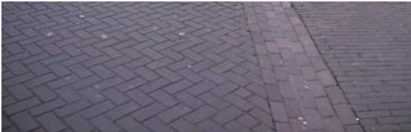
Rijbaan met molgoot (in het hart van de weg) in donker rood-paarse klinker in keperverband. Foto's zijn ter illustratie van de principes.
