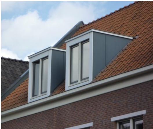
Twee dakkapellen op een dakvlak.
