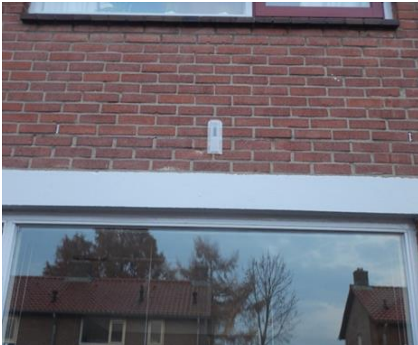
Detail exclusion flap op voorzijde woning op open stootvoeg. De open stootvoeg aan de rechterzijde is dichtgezet met een bijenbekje.
