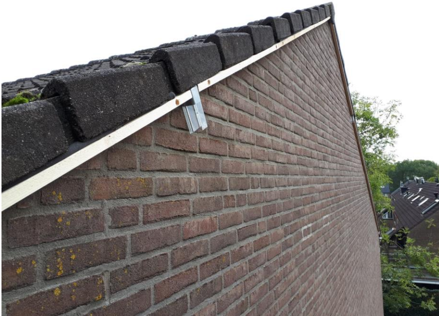
Detail exclusion flaps met panlatten en rugvulling.
