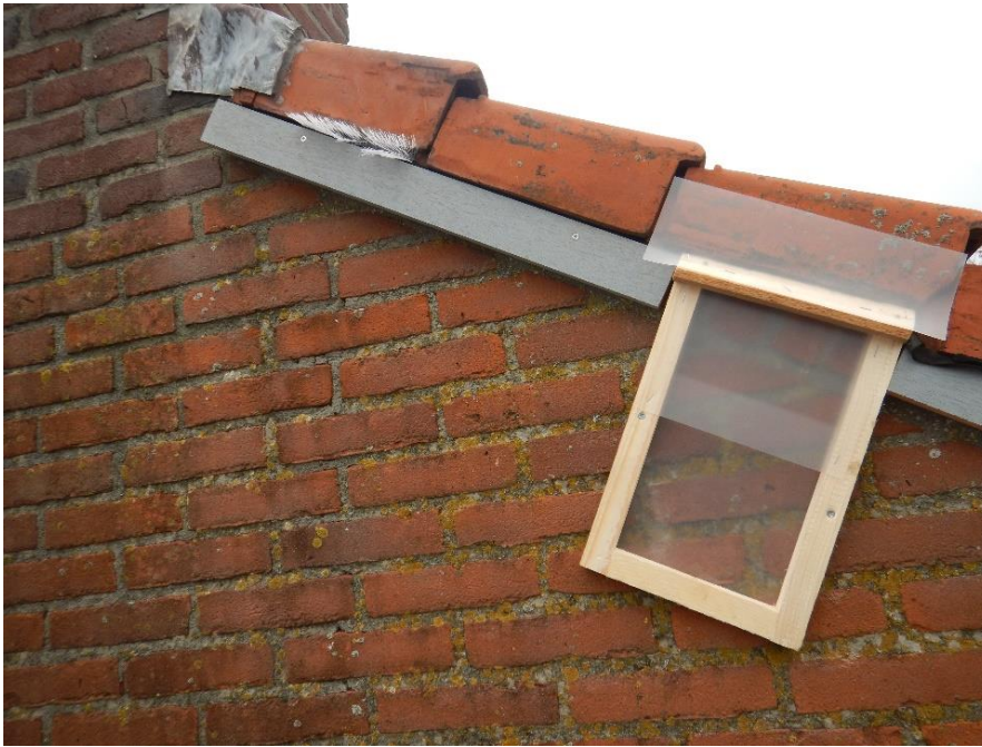
Detail exclusion flap met dichtzetten gevelpan in combinatie met gootborstels en compriband.
