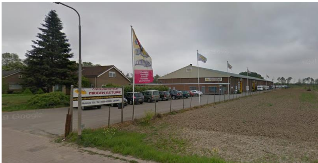
Plangebied in huidige situatie (Bron: Google Maps)
