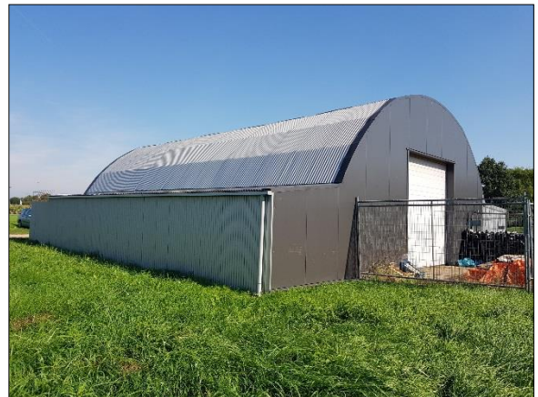
Figuur 7. Te slopen loods
