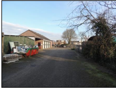
Figuur 10. Terrein gemeentewerf met te slopen bebouwing.
