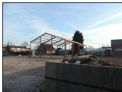
Figuur 7. Terrein gemeentewerf met te slopen bebouwing.
