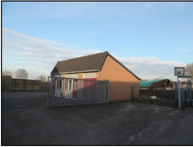
Figuur 9. Terrein gemeentewerf met te slopen bebouwing.
