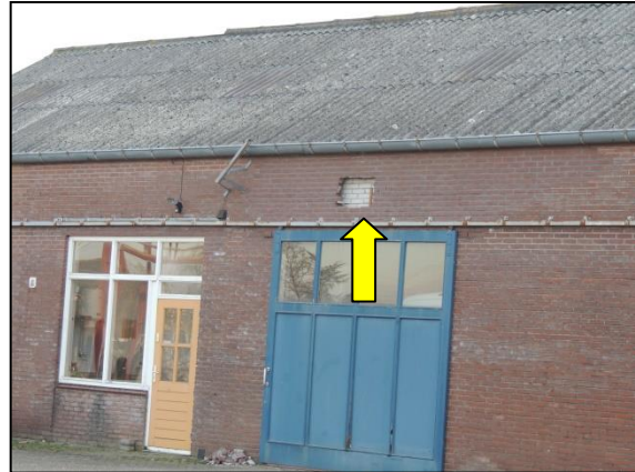
Figuur 12. Ruimtes tot de spouwmuur vormen geschikte openingen tot potentieel verblijfplaatsen voor vleermuizen.
