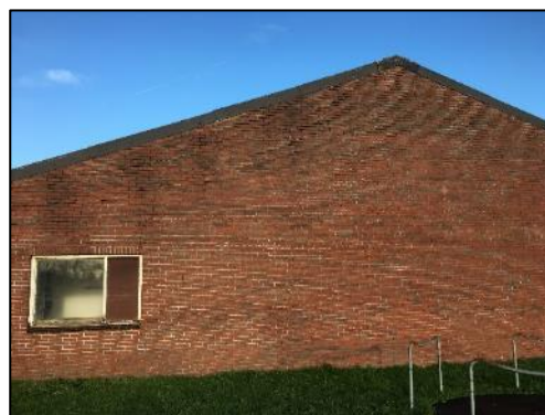
Foto 2. Zuidzijde van de loods
