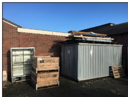
Foto 4. Verbinding met kantoorgebouw en de loods
