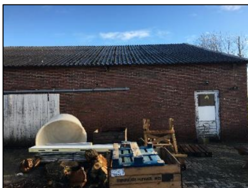
Foto 1. Westzijde van de loods
