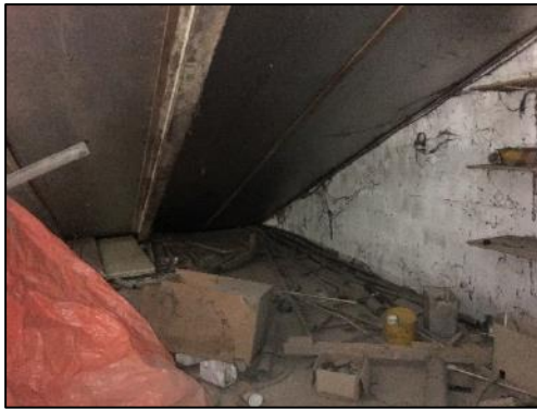
Foto 5. Zolder aan de binnenkant van de loods
