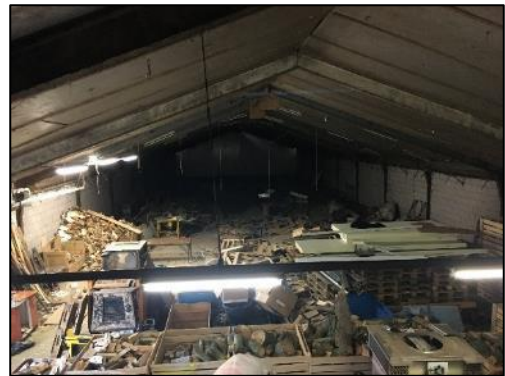
Foto 8. Binnenkant loods vanaf de zolder
