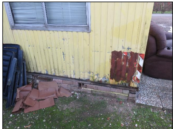
Foto 6. Onderzijde directiekeet in het plangebied
