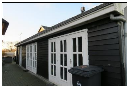
Foto 2. Westzijde bijgebouw Aalsdijk 2
