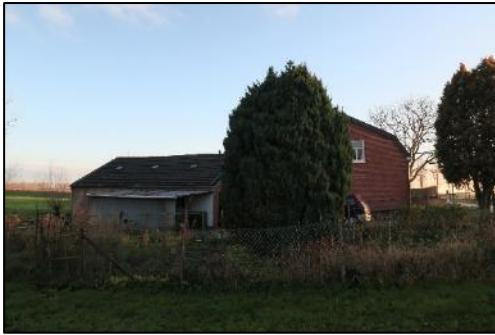
Foto 5. Schuur en woning met moestuin Aalsdijk 2
