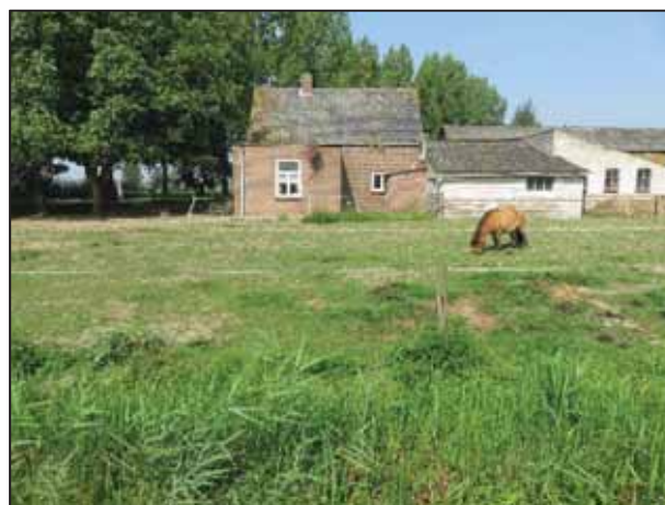
Foto 10 Te slopen bebouwing
