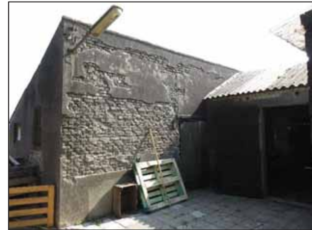
Foto 4 Te slopen schuur
