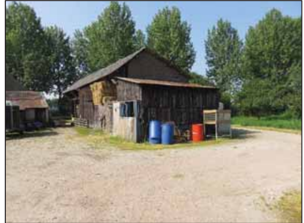
Foto 2 Te slopen schapenschuur
