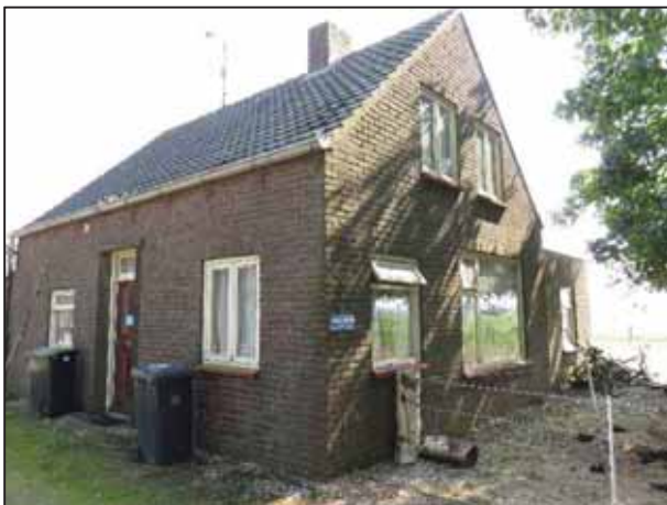
Foto 5 Te slopen oud woonhuis
