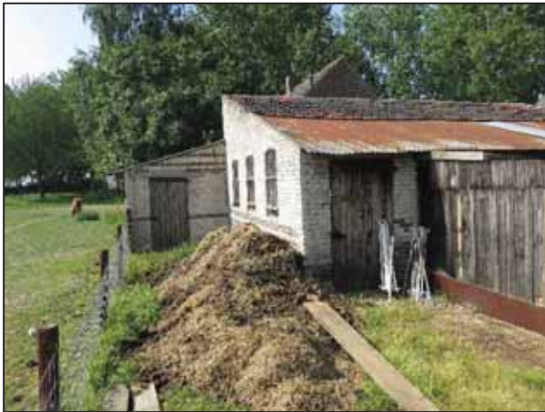
Foto 3 Te slopen schuur
