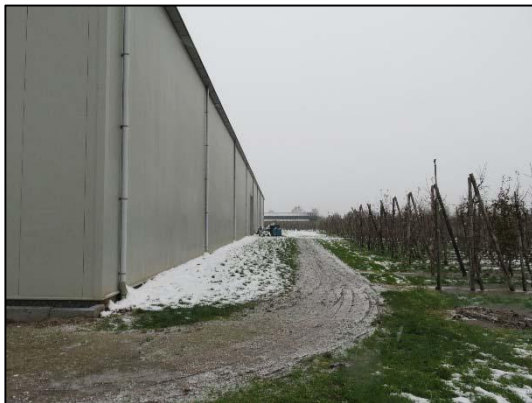
Foto 1 Achterzijde bestaande bedrijfsgebouw (vanuit zuiden)
