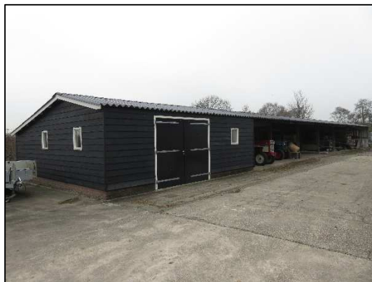
Foto 5 te slopen schuur
