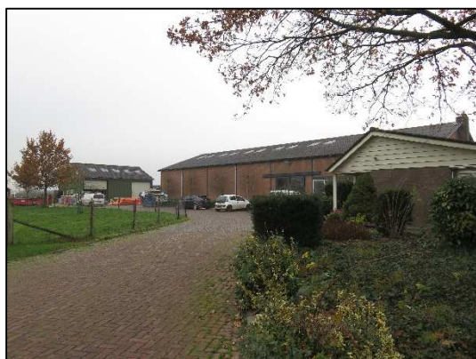
Foto 1 overzicht plangebied; te slopen gebouwen
