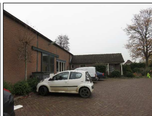
Foto 4 te slopen loods en kantoorpand
