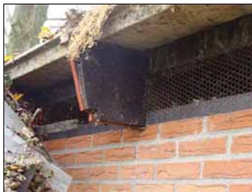
Foto 9. Verwijderd boeiboord en openingen afgedekt met gaas
