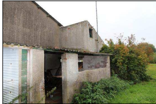
Foto 6. Te slopen schuur (noordzijde)
