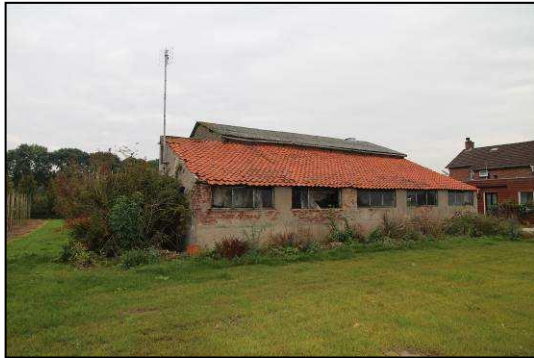
Figuur 5. Te slopen schuur (westzijde)
