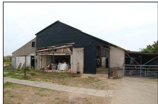
Foto 2. Te slopen schuur (zuidgevel)
