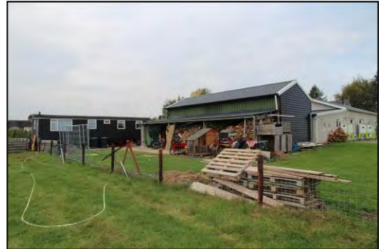
Foto 4. Aanwezige tramwagon, hoge schuur en kapschuur.
