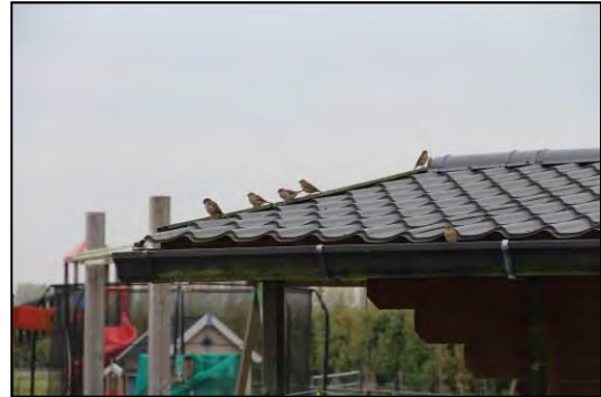
Foto 6. Huismussen op dak 'dierenverblijf/tuinhuis'
