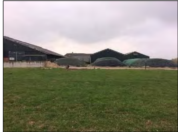
Foto 2. Bestaande ruwvoeropslag aan achterzijde stallen
