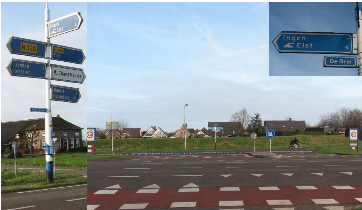
Figuur 5. Oostelijke toegang naar Ingen. Links: bewegwijzering vanaf de N320 (Kesteren-Tiel/Culemborg). Rechts: op de voorgrond de N320 met aan weerszijden een vrij liggend fietspad. Aan de overzijde de Dr Guepinlaan naar Ommeren met een vluchtheuvel en een drempel bij het begin van de 60 km/uur-zone. De Guepinlaan buigt af naar rechts; meteen aan de linkerzijde is de afsplitsing naar De Brei, met nogmaals een wegwijzer naar Ingen/Elst (inzet rechtsboven).
