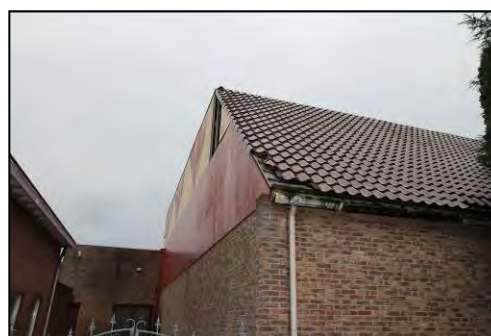
Foto 2. Te slopen bedrijfspand
