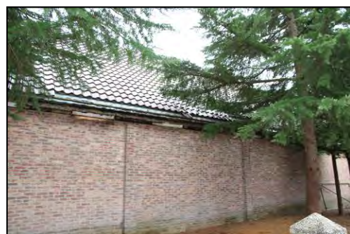
Foto 3. Zijgevel te slopen pand
