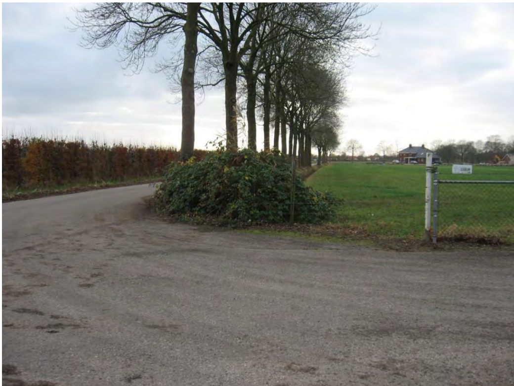
Figuur 17. De bedrijfstoegang biedt voldoende ruimte voor het wachten op eventuele tegenliggers die de bocht al gepasseerd zijn. Tegenliggers zijn al eerder vanaf de bedrijfsweg te zien (vergelijk de vorige figuur), maar vervolgens ook vanaf deze plek, mits de wilde bramen weggehaald worden.
