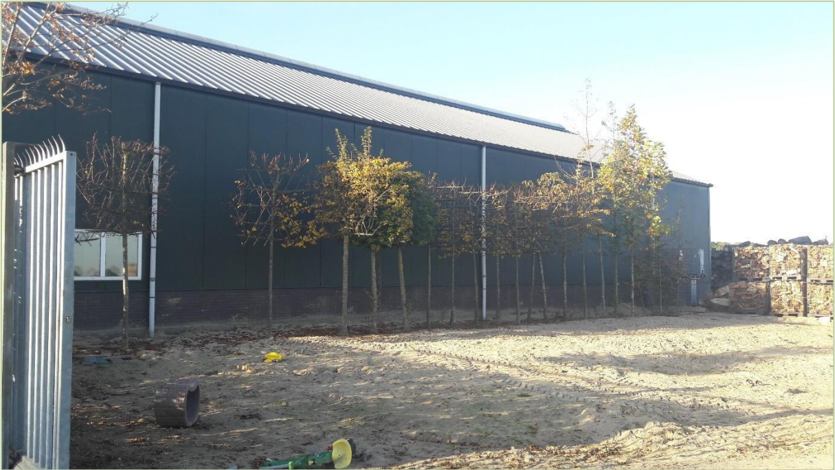
Afbeelding 2. Locatie waar realisatie van de overkapping zal plaatsvinden.
