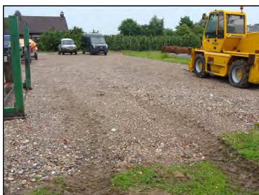
Foto 5. Bouwlocatie van zuidkant af gezien
