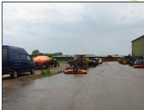
Foto 2. Bouwlocatie en geasfalteerd middenstuk
