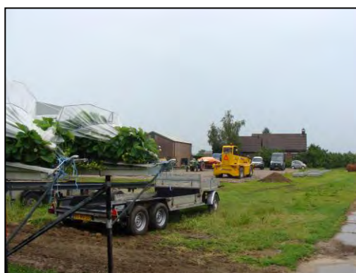
Foto 6. Bouwlocatie en woonhuis
