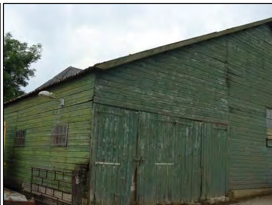
Foto 4. Te slopen schuur
