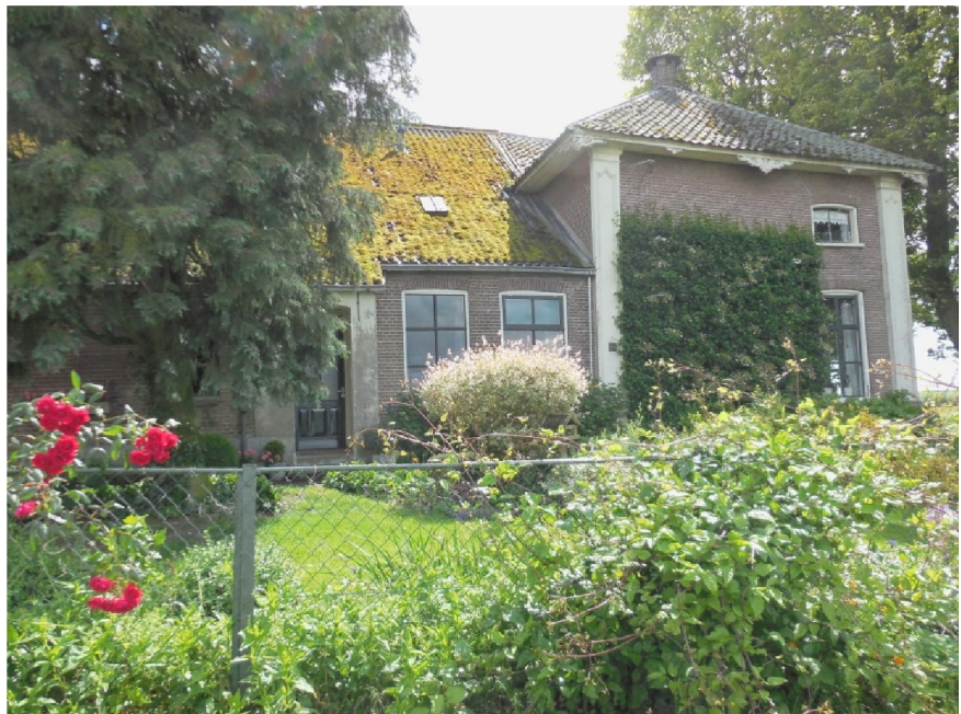
Foto van de noordzijde van de monumentale boerderij
