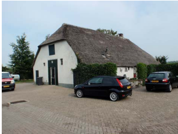
Afbeelding 1: Overzicht bestaand woonhuis
