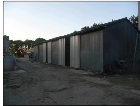
Wagenloods van damwandprofiel
