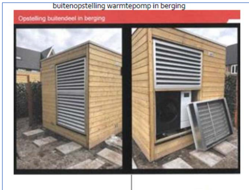
Figuur II.1 opstelling warmtepompen
