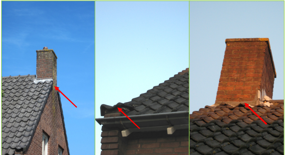
Figuur 2: Invliegopeningen voor gierzwaluwen onder de dakpannen (zie rode pijlen). Foto's: M. van der Sluis.
