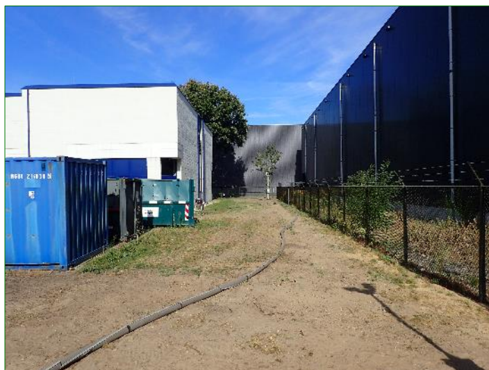
Impressie van de reeds geprepareerde grond waarin kabels worden ingegraven.
