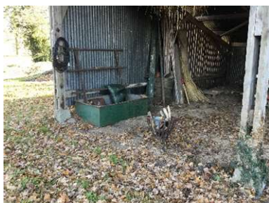
Foto 7 Vml. bovengrondse tank
